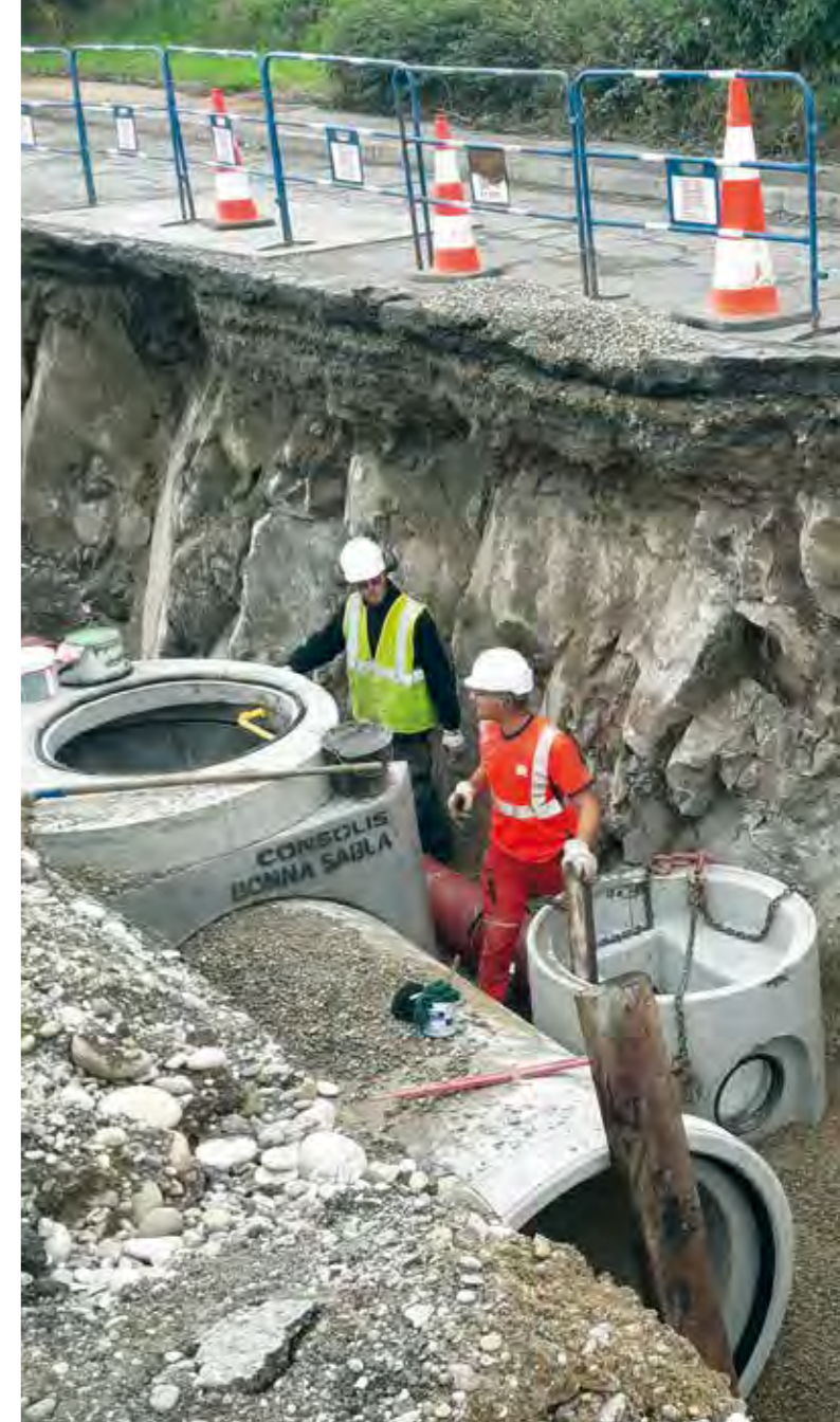
Réhabilitation de la tranche 2 du collecteur d'eaux usées desservant la zone d'activité des Platières à Mornant.
